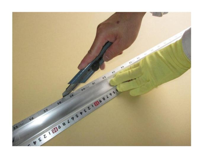
ボードを切るときに、定規を押さえて、 押さえた手より、前からカッター使用 しないこと。カッターが定規より外れ て、手の負傷につながる。
